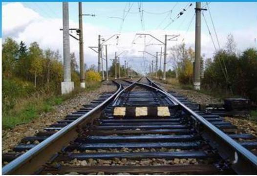
Разъезды представляют собой раздельные пункты на однопутных железнодорожных линиях, имеющие путевое развитие, предназначенное для встречения и обгона поездов
