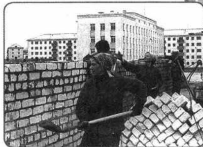
На стройке. Начало 1960-х гг.
