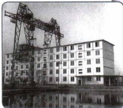
Экспериментальный жилой дом в районе Новые Черёмушки в Москве, построенный за 5 дней. 1962 г.
