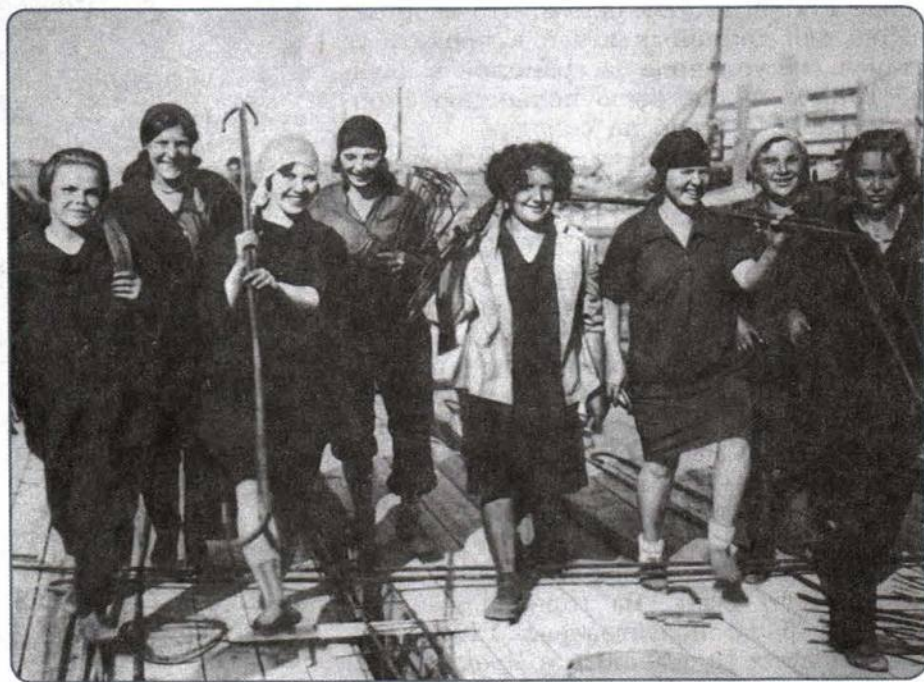
Женская строительная бригада. 1931 г.
